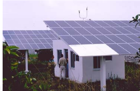
Bombagem de água
